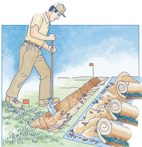
In primul rand asezati o folie de plastic si indepartati gazonul, apoi sapati santuri adanci de 30cm pentru conducta principala, si santuri de 15-20cm pentru liniile laterale
