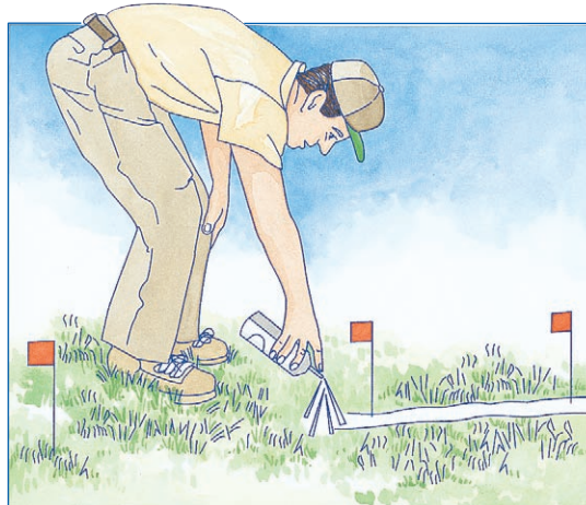
Inainte de saparea santurilor folositi stegulete de marcaj si vopsea pentru a marca traseul conductelor sistemului
